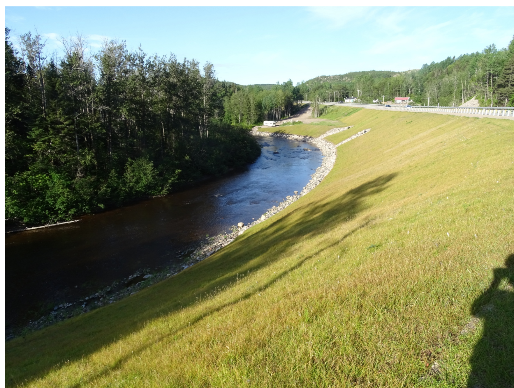
Figure 9 : Exemple du site sur le terrain (talus stabilisé)
