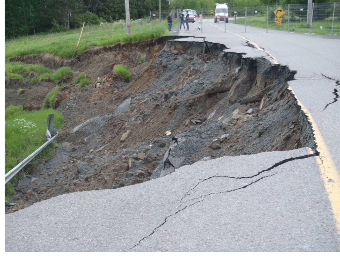
Figure 1: Exemple de dommage engendré par un glissement.
