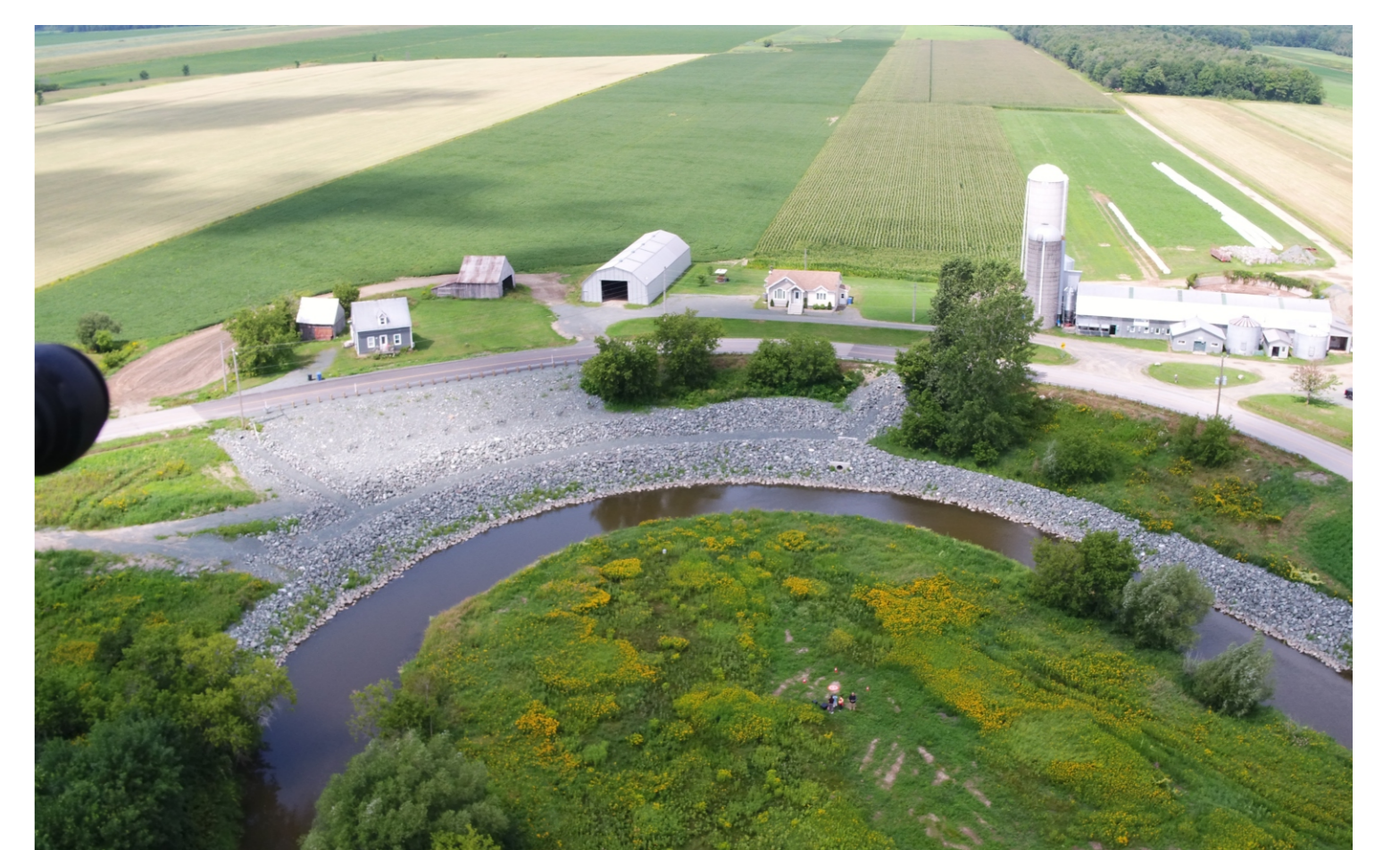
Figure 12 et 13 : Glissement survenu à St-Célestin avec la représentation du talus stabilisé.
