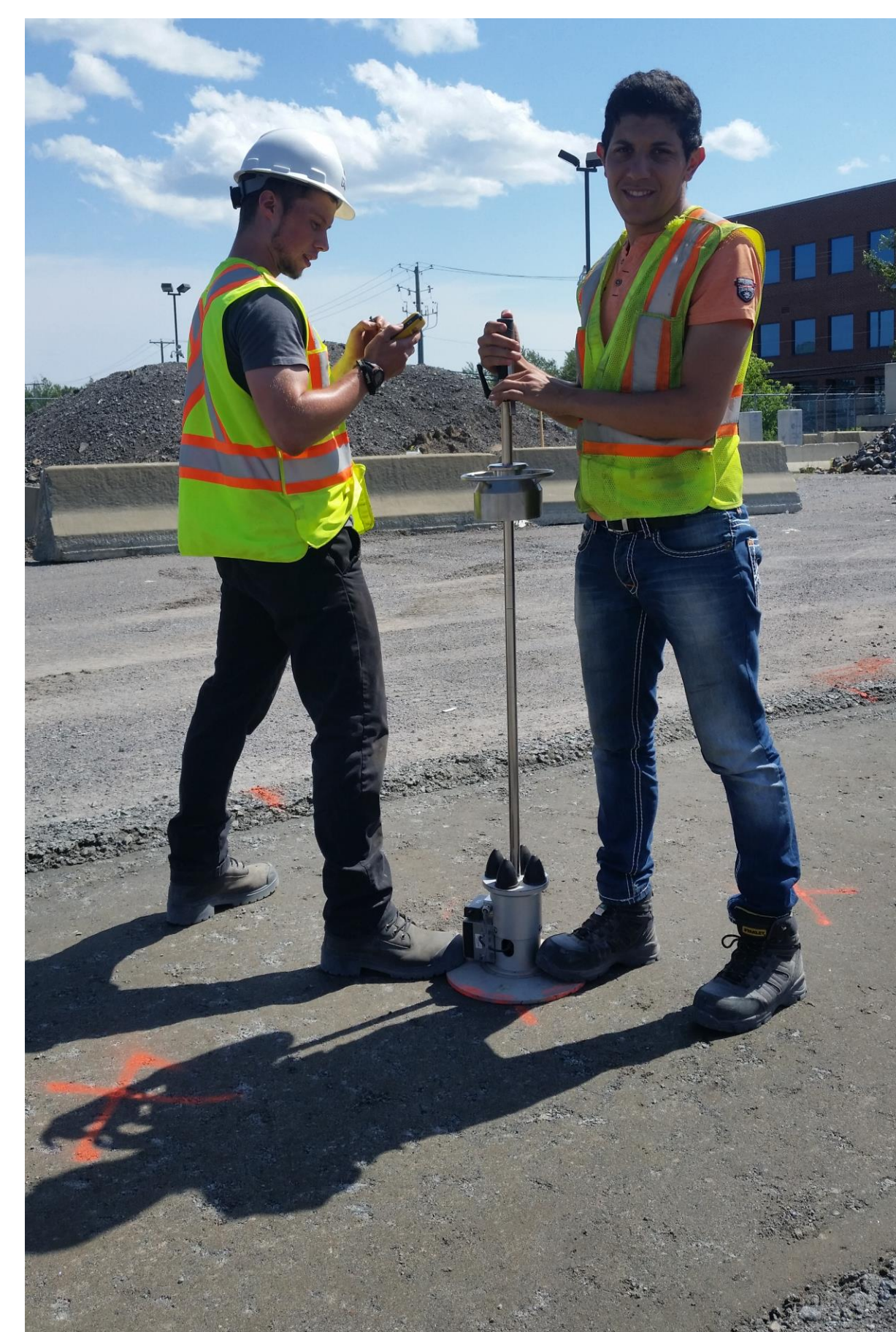
Figure 5: Prise de données avec le défectomètre portable à masse tombante sur la planche d'essai compactée.
