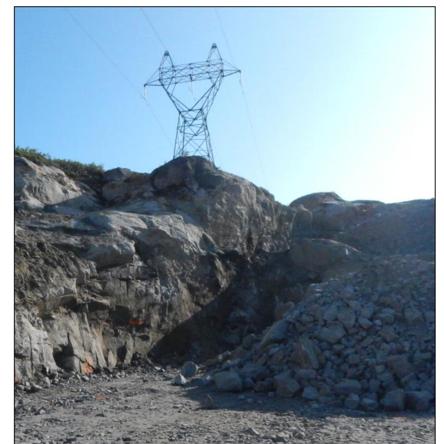
Figure 3: Chantier de coupe de roc près de la ville de Franquelin
