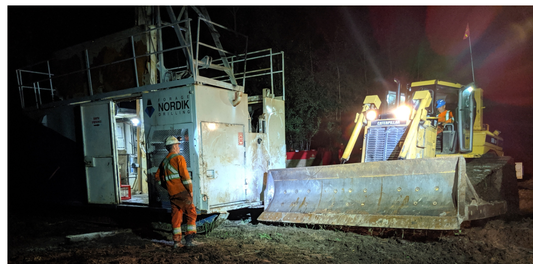
Figure 8 : Alignement d'une foreuse
