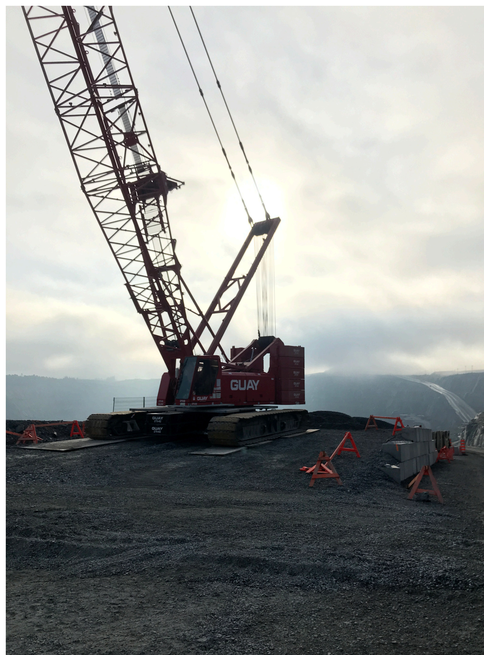
Figure 4 : Plateforme de roches pour une grue dans la rampe principale de la fosse Canadian Malartic.
