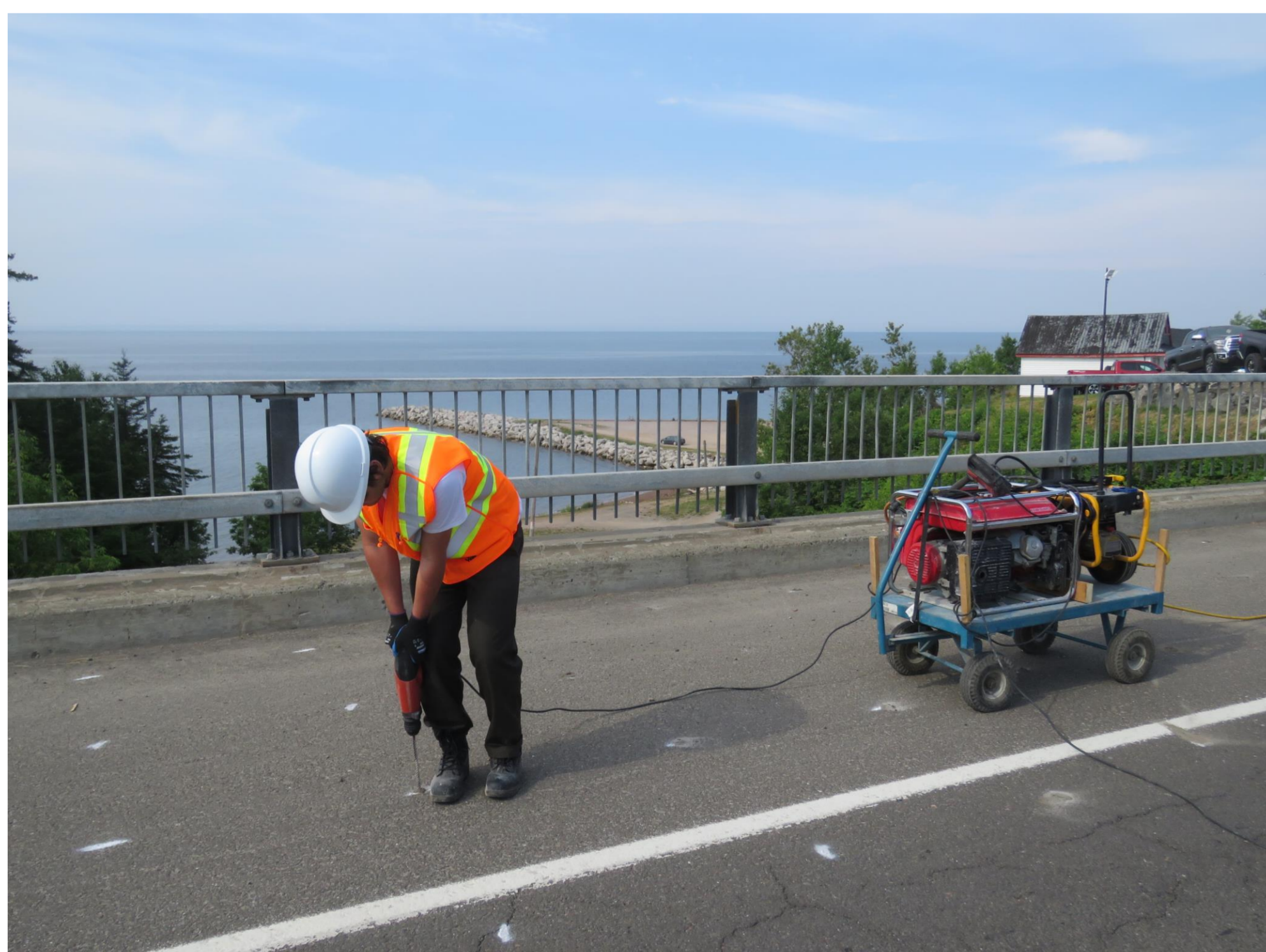
Figure 2 : Perçage de trou pour la réalisation de l'essai de potentiel de corrosion, Caplan, QC. Photo : Nadia Pouliot
